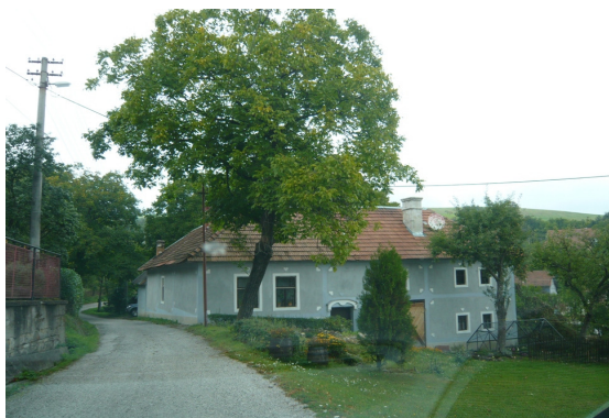
pohľad na chalupu v usadlosti Svinárky, zdroj: autor, 2008
